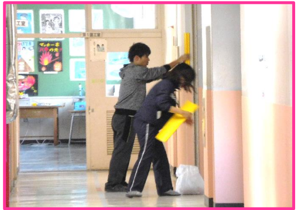
【廊下の緩衝材取り付け】
