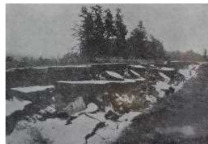
地震で地割れした 木津用水の堤防
