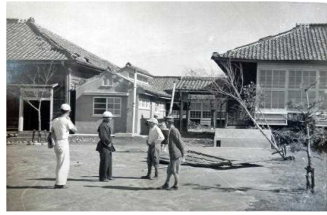
傾いた木の後ろが飛ばされてきた屋根
